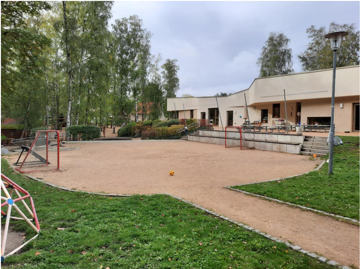
Neubau ging 2013 in Betrieb
